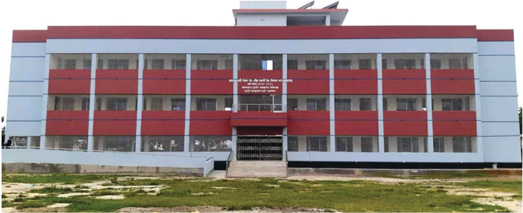
বন্যাশ্রবণ ও নদীভাঙন এলাকায় নবনির্মিত বন্যা আশ্রয়কেন্দ্র, বাঙ্খারামপুর, ব্রাহ্মণবাড়িয়া Newly built flood shelter in the flood prone and river erosion areas, Banchharampur, Brahmanbaria
