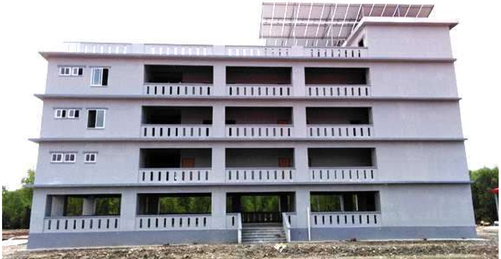
ভাসানচরে নবনির্মিত ঘূর্ণিঝড় আশ্রয়কেন্দ্র Newly constructed Cyclone shelter in Bhasanchar
